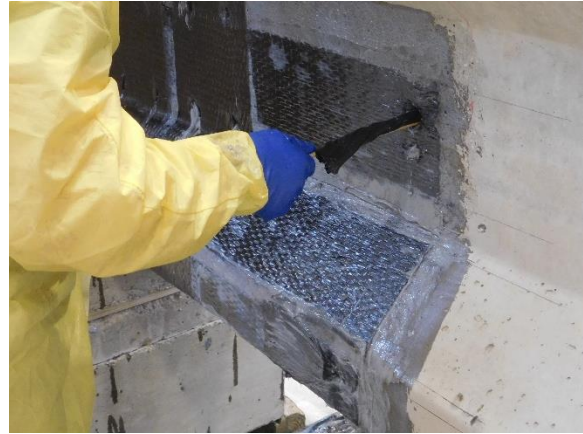
(d) Removing Wooden Dowel
