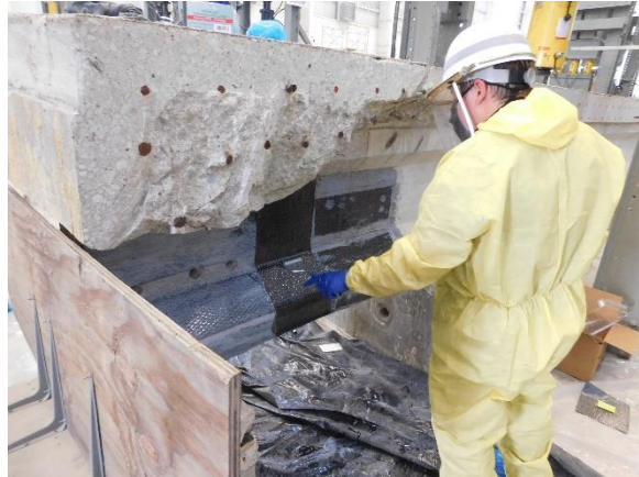
(d) Rolling FRP to Eliminate Air Pockets
