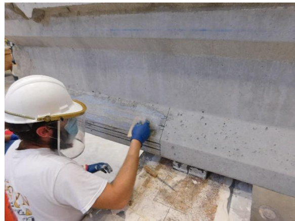
(d) Leveling Off Excess Epoxy Grout
