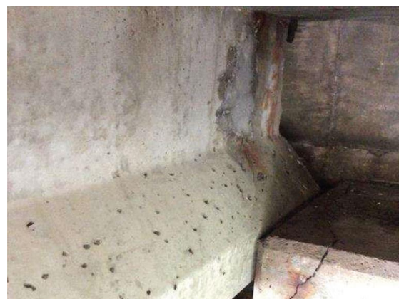
(b) Web Deterioration
